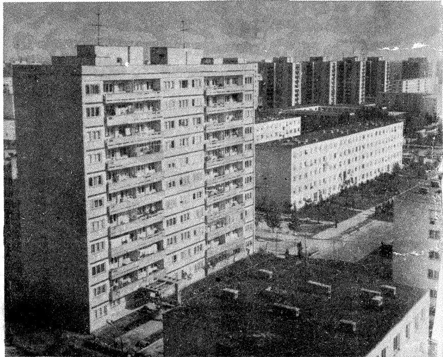
Ploiești-Vest, cel mai tînăr cartier al municipiului, a fost, de la deschiderea lucrărilor, locul de muncă al sutelor de elevi din Liceul industrial de construcții.
